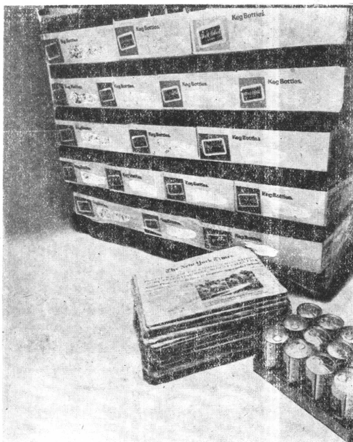
图5 用聚乙烯收缩薄膜包装报纸和啤酒。
