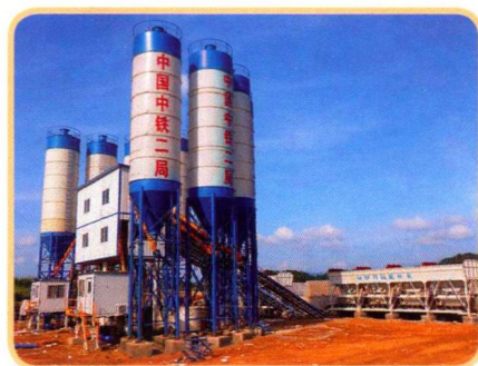
凯羊高速KT6合同段拌合站
