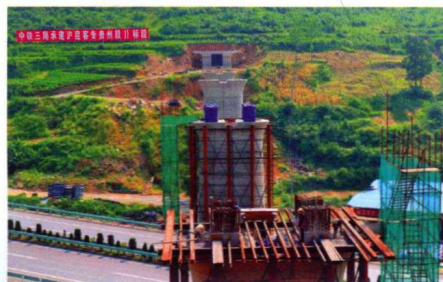
沪昆客专跨公路大桥施工
