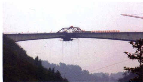
大桥合拢施工
