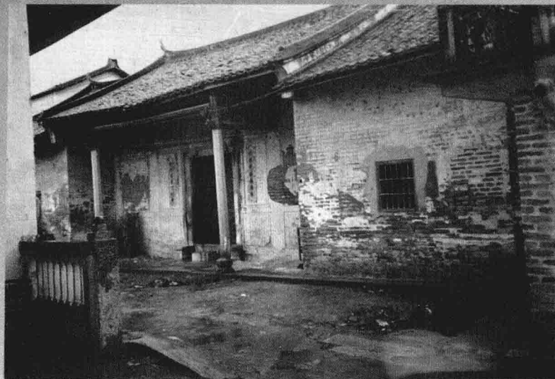
◀原丰顺县城 (现丰良镇) 彭 氏宗祠“光裕 堂”外貌
