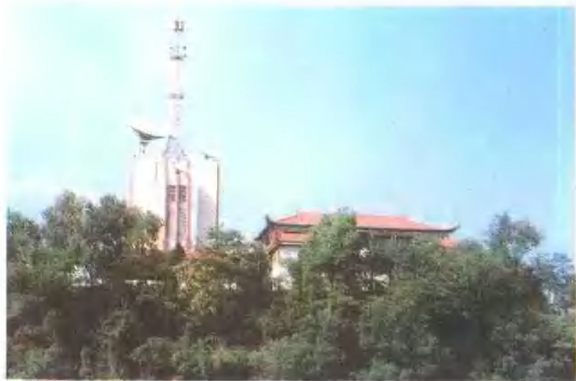
竹溪县电视塔
