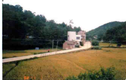
铺筑满堂村4公里水泥路2002年11月20日竣工。
