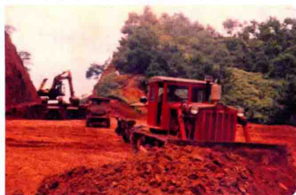
1995年6月兴建满堂乡村公路（机械施工、马鞍坳一角）。
