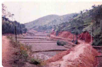
1988年冬兴建满堂村机车路，马鞍坳至中心村村道改线工程一角。
