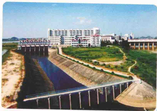
沙坪河排涝站
