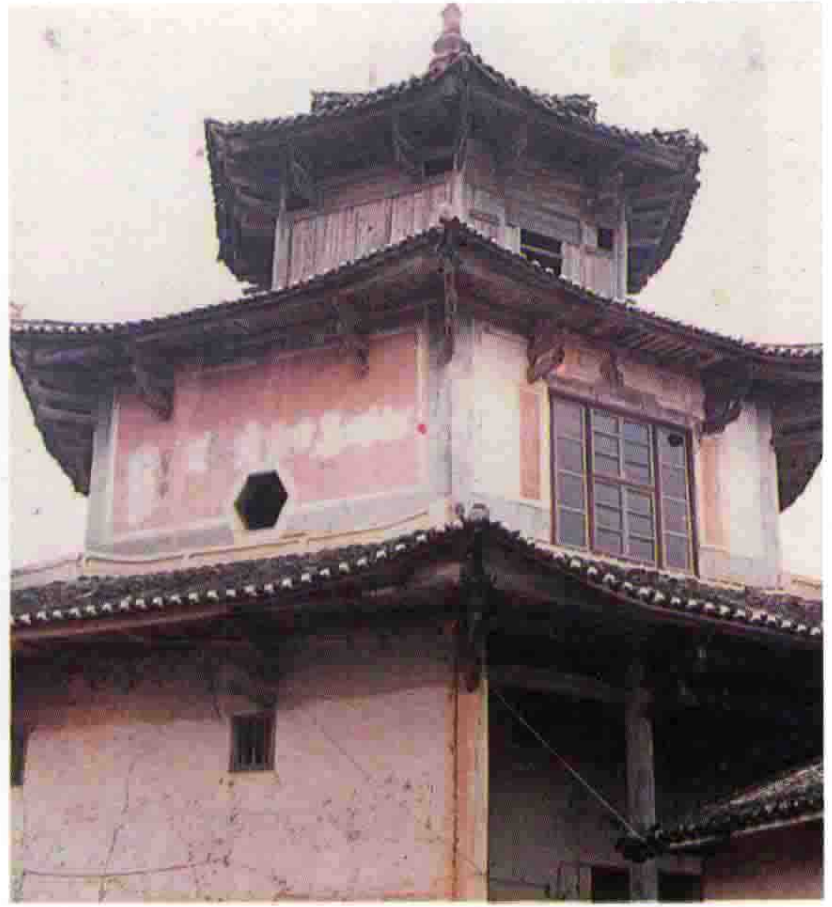
← 通江西古道旁的邹坊八角亭， 建于清乾隆五十九年（公元1794年）。
