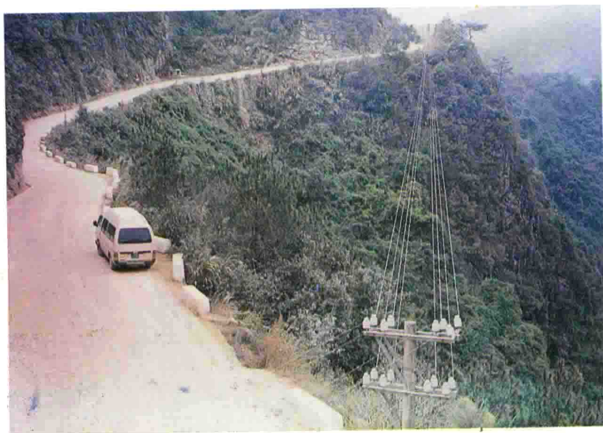
→ 在悬崖峭壁中筑成的蕉步线傍山公路
