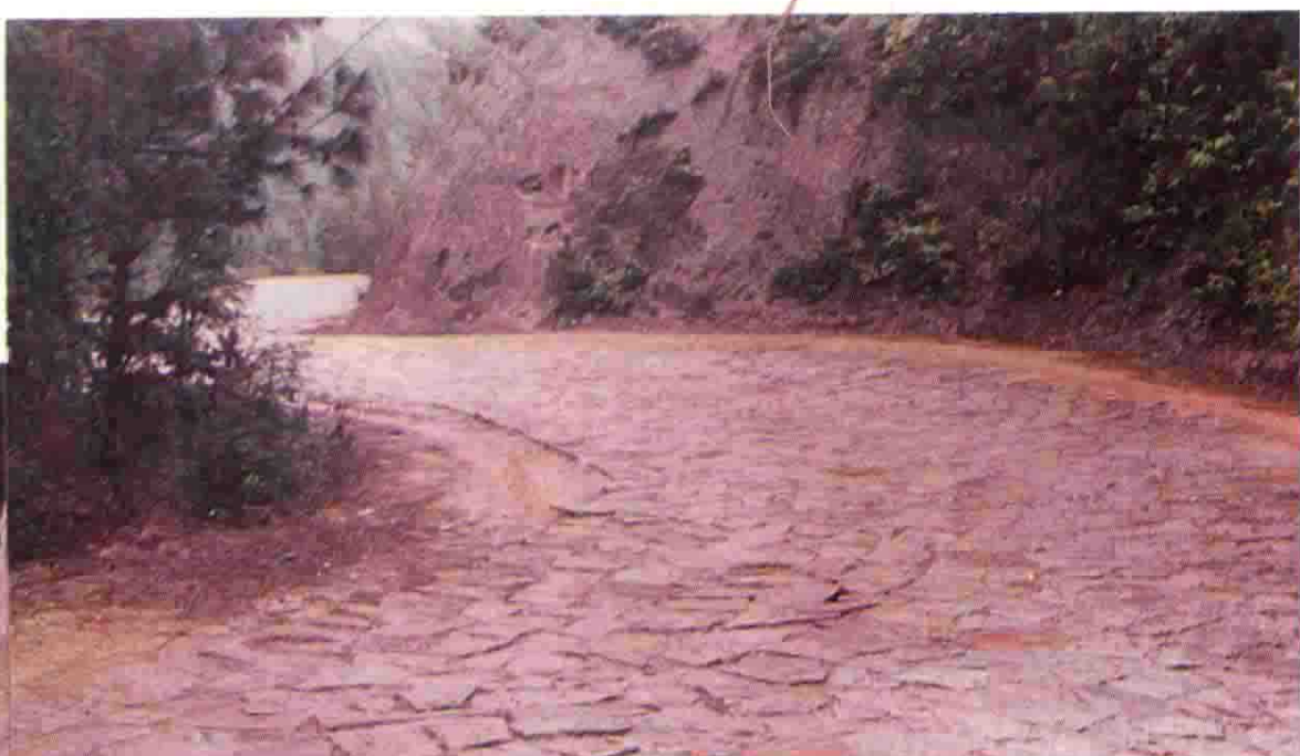
↑ 油汤线陡坡路段的块石路面
