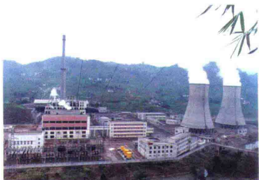
涪陵龙桥火电厂厂区全景
