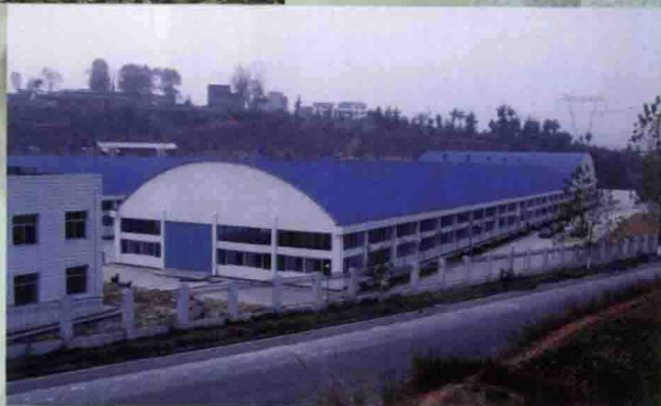
▲ 杭州娃哈哈集团宜昌公司厂区一角
