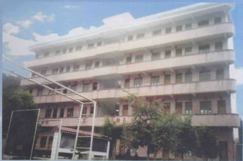
广东梅州市岭东中等职业学校教学大楼
