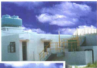
污水处理系统 Sewage disposal System
