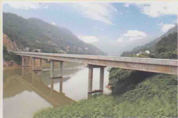
▲新建造的青溪汀江大桥
