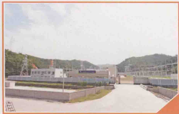
▲ 220千伏大埔（土岭）输变电站建成
