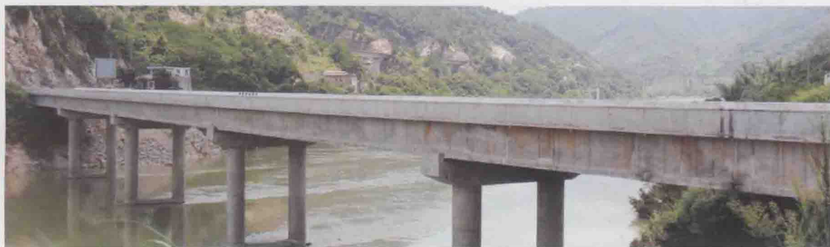
新建成的青溪汀江大桥
