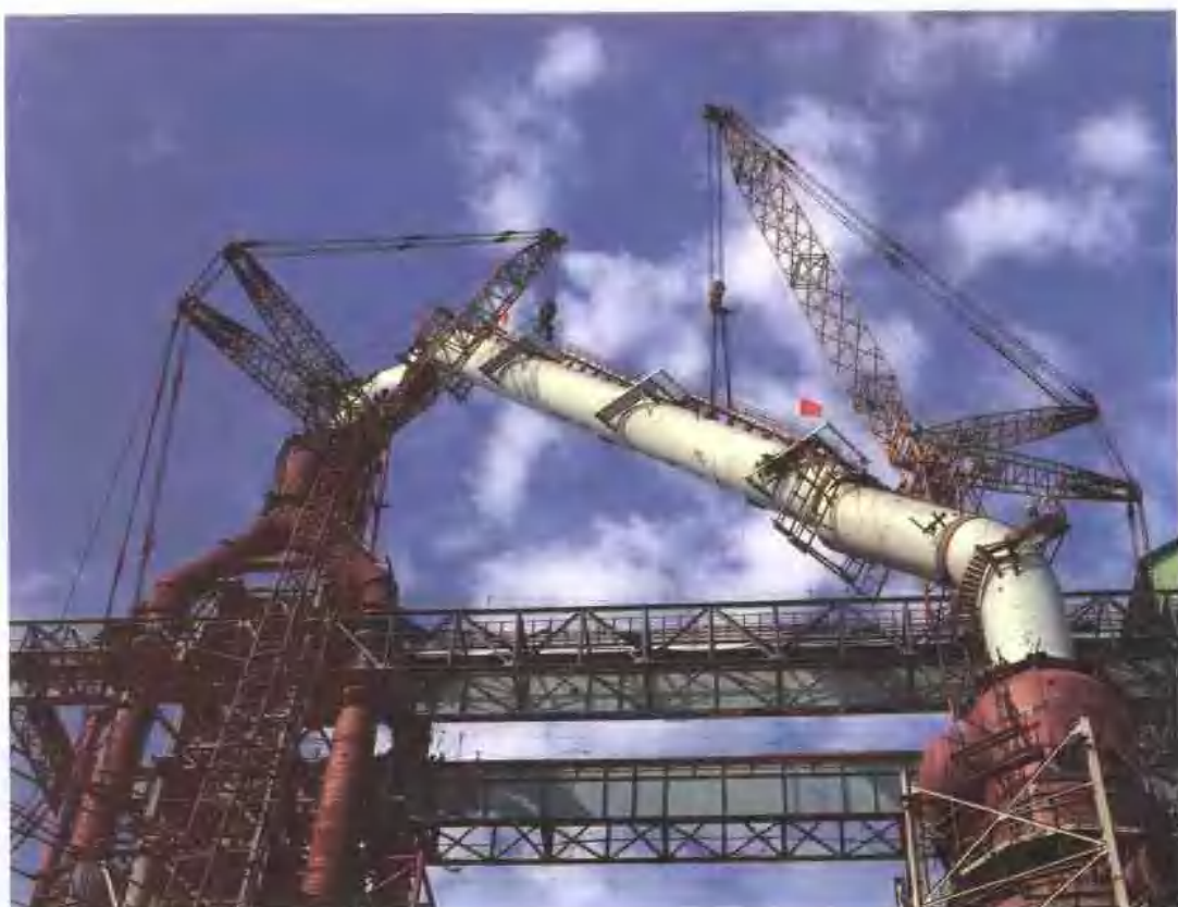
吊装新三号高炉煤气下降管
