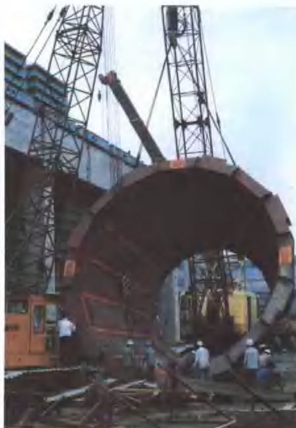
混匀料场在建设
