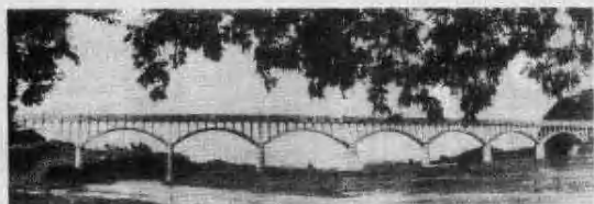
玉溪河水利工程邛崃解放渡槽
