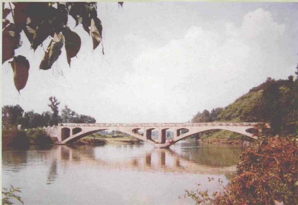
民族经费补助修建的欧阳大桥
