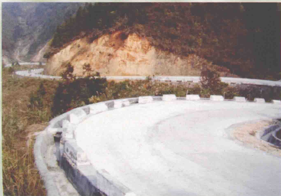
民族经费补助修建的锦屏至湖南靖州公路
