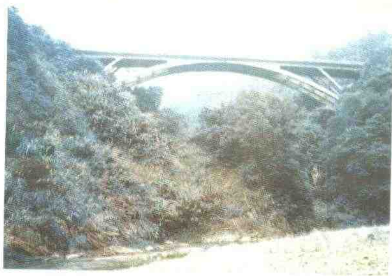
国道 105 线徐坑高架桥
