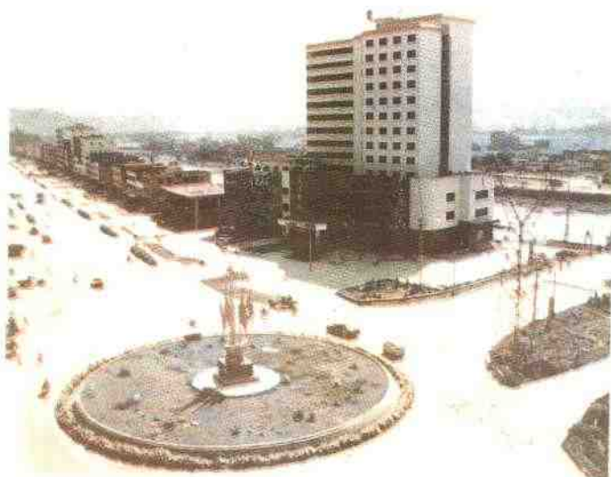
国道 105 线新丰县城路段
