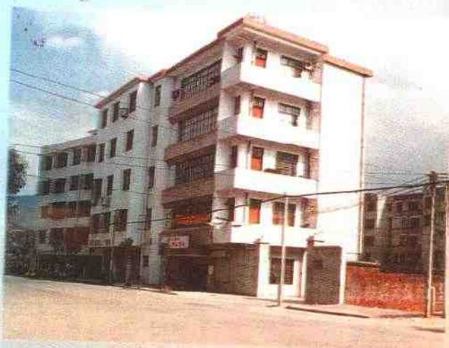
新丰县公路局办公楼
