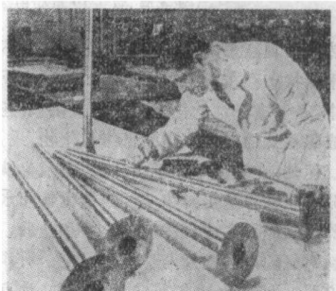
照片10 与湿的氯一样,热和振动对钛制喷雾器管的实际应用也不成问题。钛管没有实用价值,塑料管用3个月就坏了。
