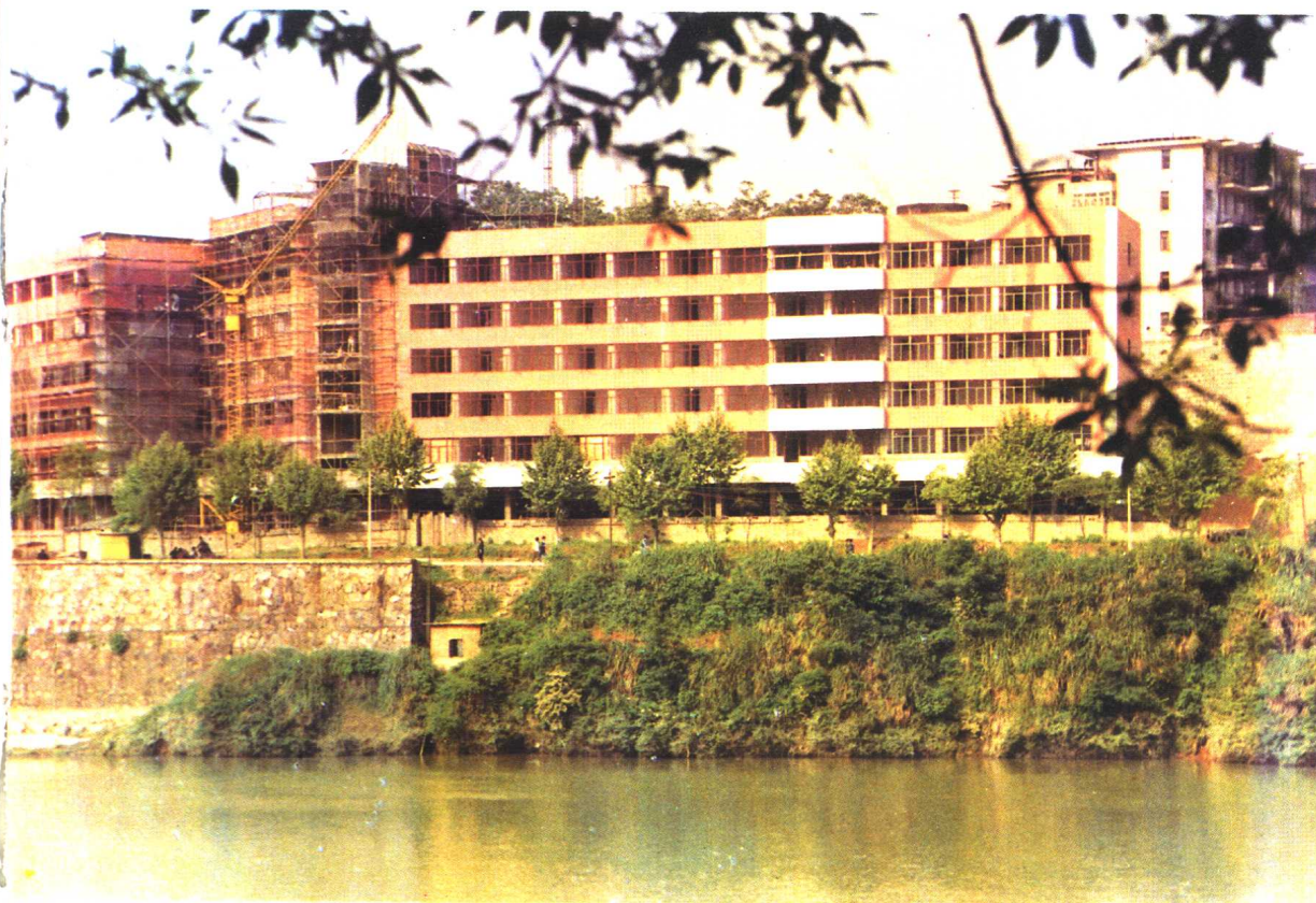
即将落成的市劳动就业培训中心大楼
