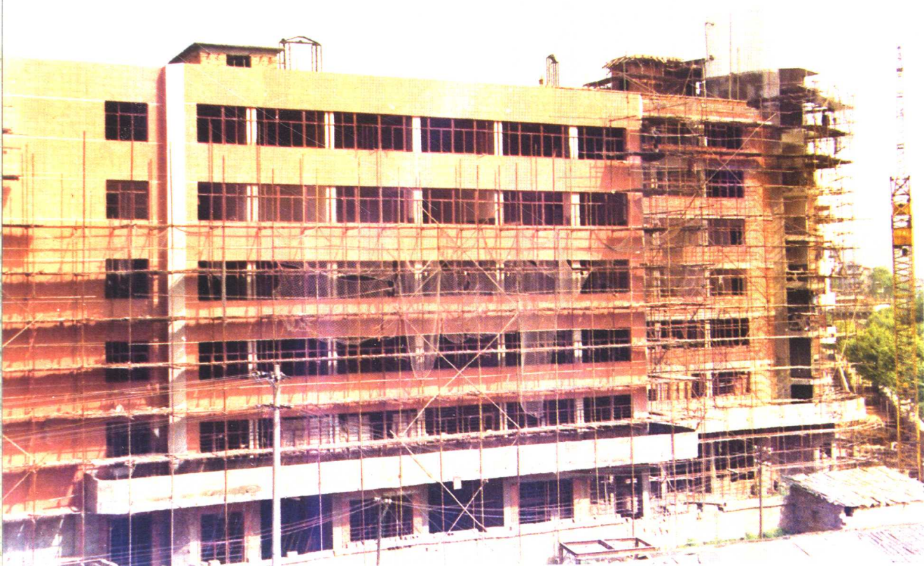
正在兴建中的市军队转业干部培训中心大楼
