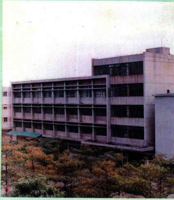
梅县市粮食局办公大楼
