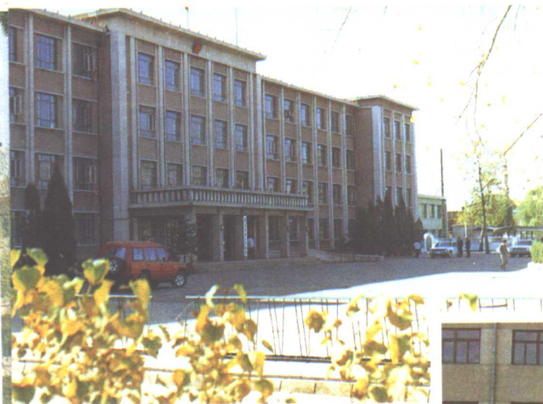
秦皇岛市政府办公大楼
