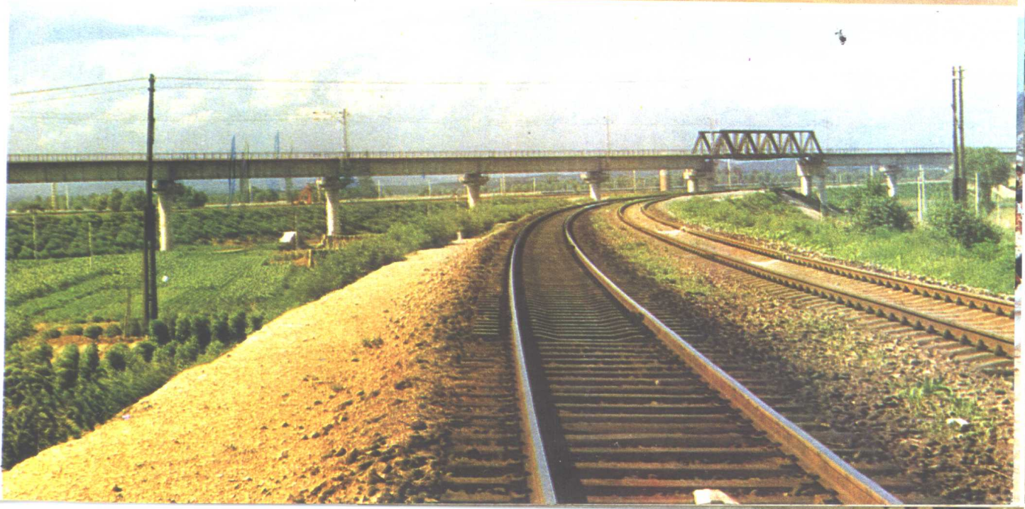
京山、京秦铁路汤河特大桥
