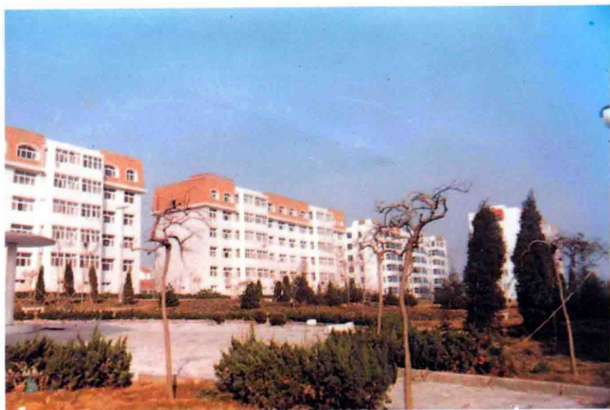
薛家岛梧桐园居民小区
