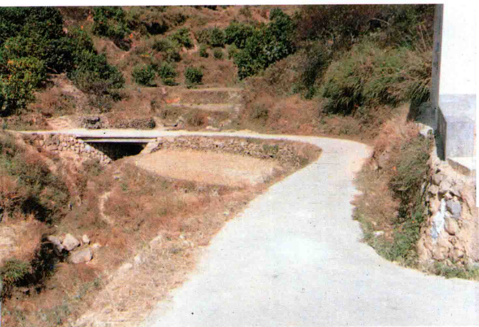
↑ 石楼同心 水泥路
