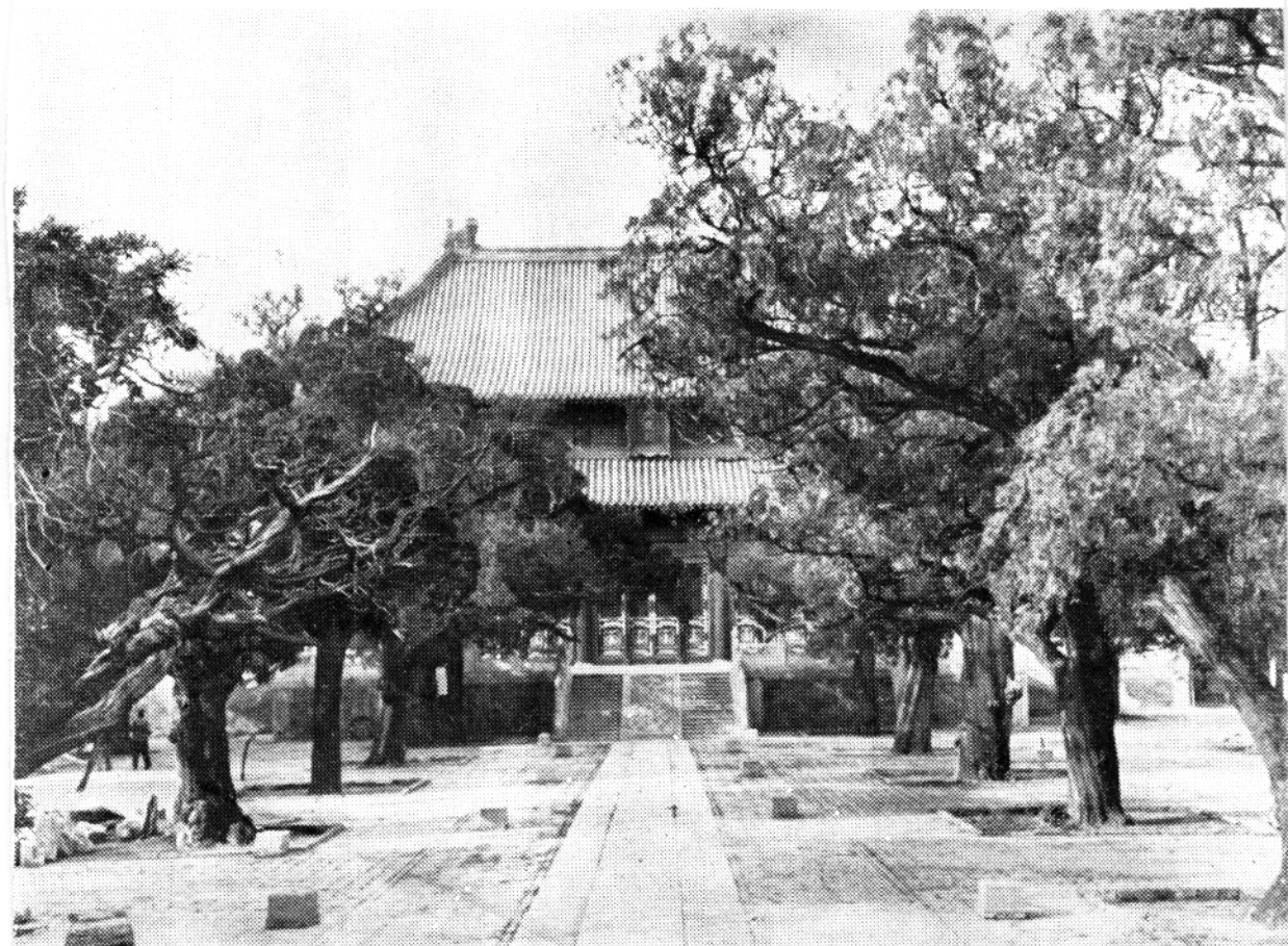
大成殿——孔庙的正殿。面阔九间，进深五间，崇台高阶，重檐庑殿顶，饰黄琉璃瓦，建筑雄伟，蔚为壮观。
