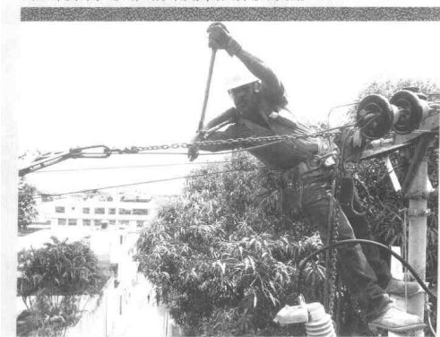
加拉加斯电力局的一名工作人员在维修委内瑞拉瓦格州的电线。
