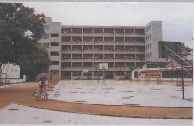
▲汤坑镇第一小学教学大楼。
