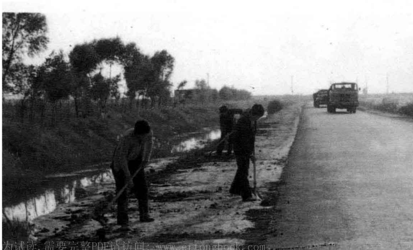
16. 道班工人在整修路肩
