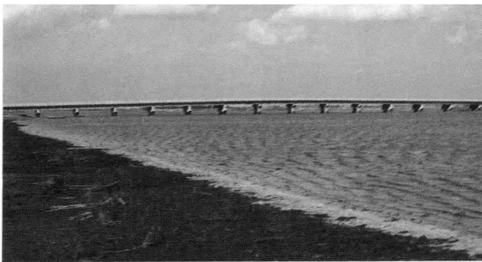
6. 大港油田专用公路青龙河钢筋混凝土大桥
