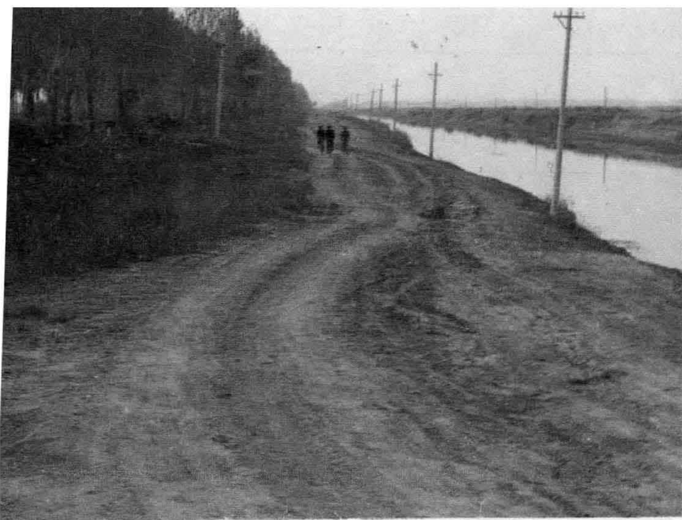
3. 兴建河北省国营柏各庄 农场初期修建的土路
