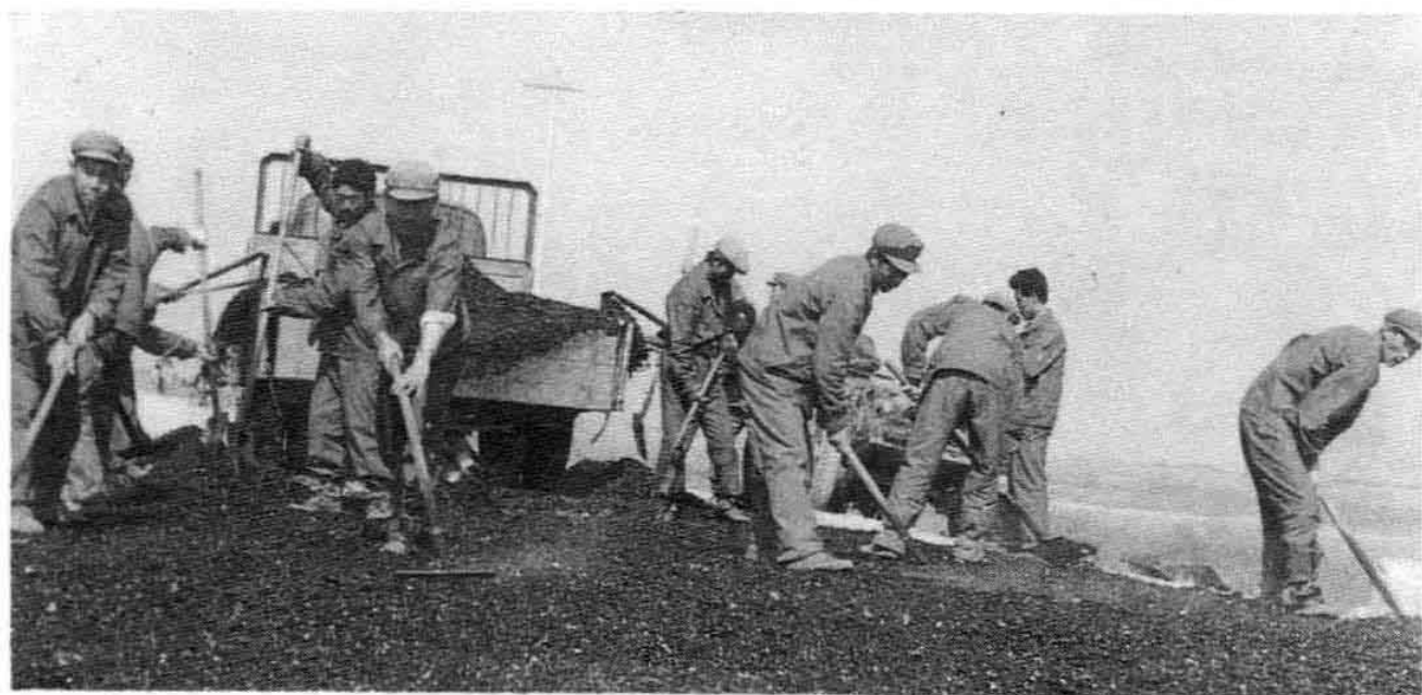
筑路职工在铺 17。筑路职工在铺 筑沥青路面
