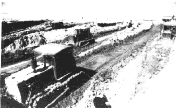
9 神丰路改线工地
