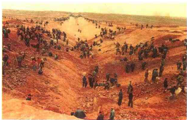
襄阳县民工在开挖引丹工程主干渠
