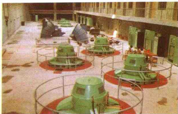
清泉沟泵站机房
