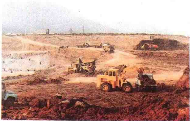
施工中的清泉沟泵站正在开挖泵站基坑
