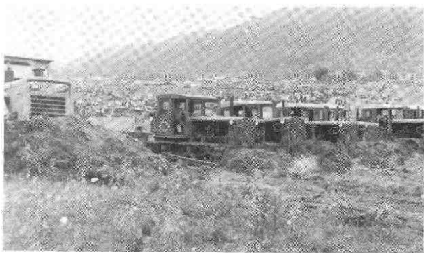
在引丹工程中，数量有限的施工机械发挥了开路先锋的作用。
