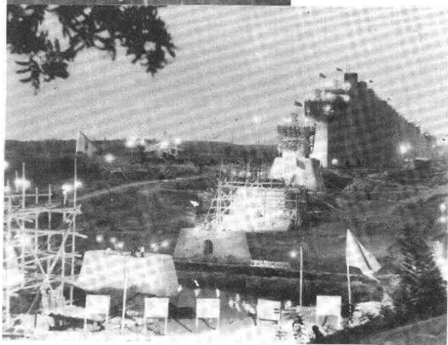
正在施工中的排子河渡槽
