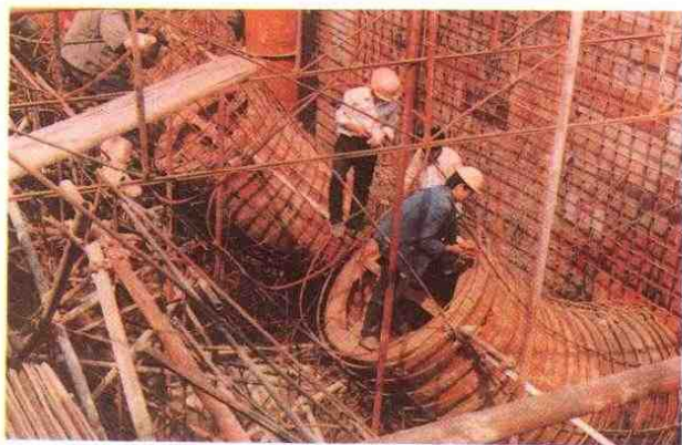
清泉沟泵站正在紧张地施工，这是钢筋工在绑扎钢筋
