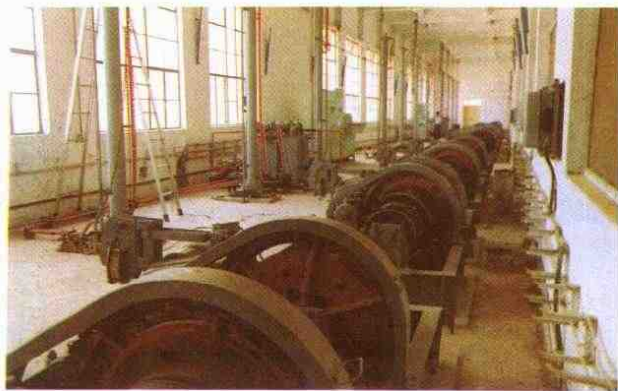
清泉沟泵站机房
