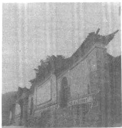
(七) 兰坪县营盘镇杨玉科爵府遗址的照壁。
