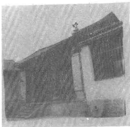
(八) 兰坪县营盘镇杨玉科建造的家祠遗址。
