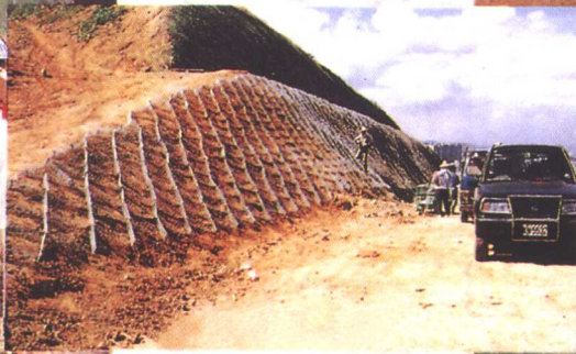
鋼網固定框綠化植生
