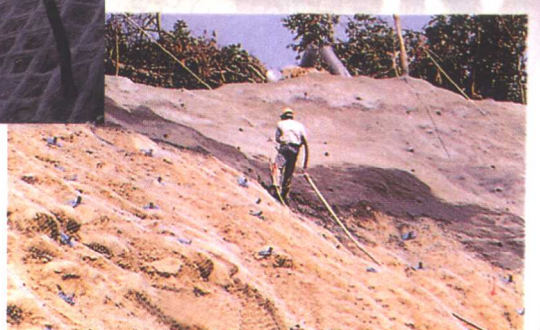
邊坡水泥噴漿工法
