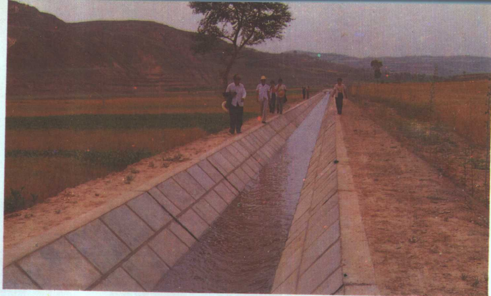
万亩灌区——横渠干渠
