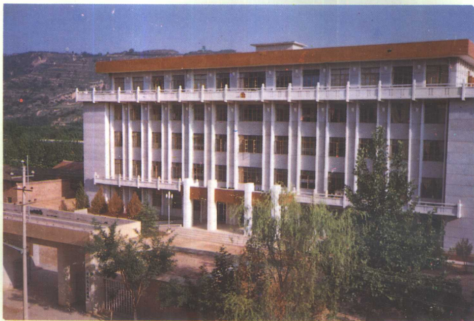
⑦ 灵台县人民政府办公楼
