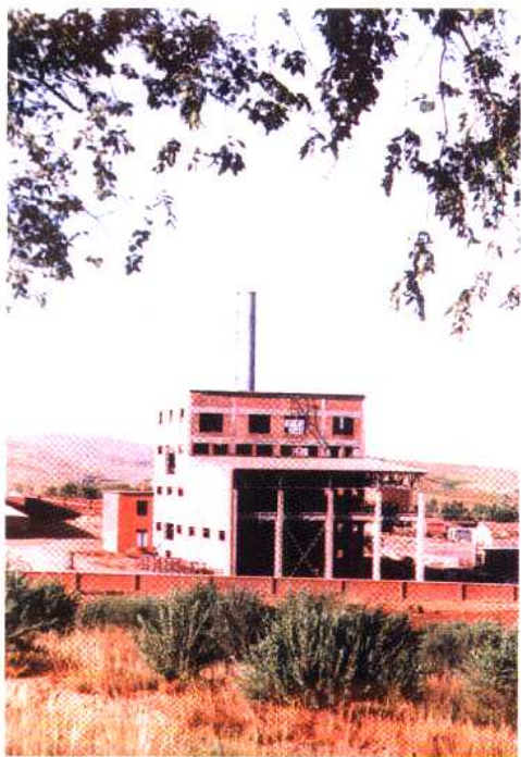
化德县鑫铁厂—2500千瓦安硅铁矿热炉
