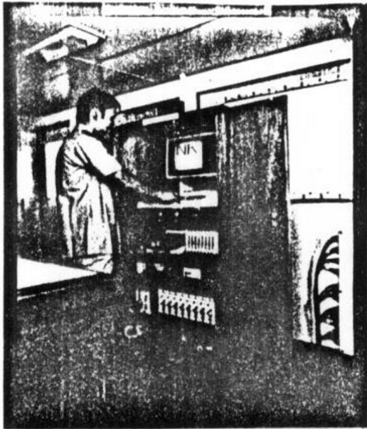
照片 在船上的船体强度监测系统
