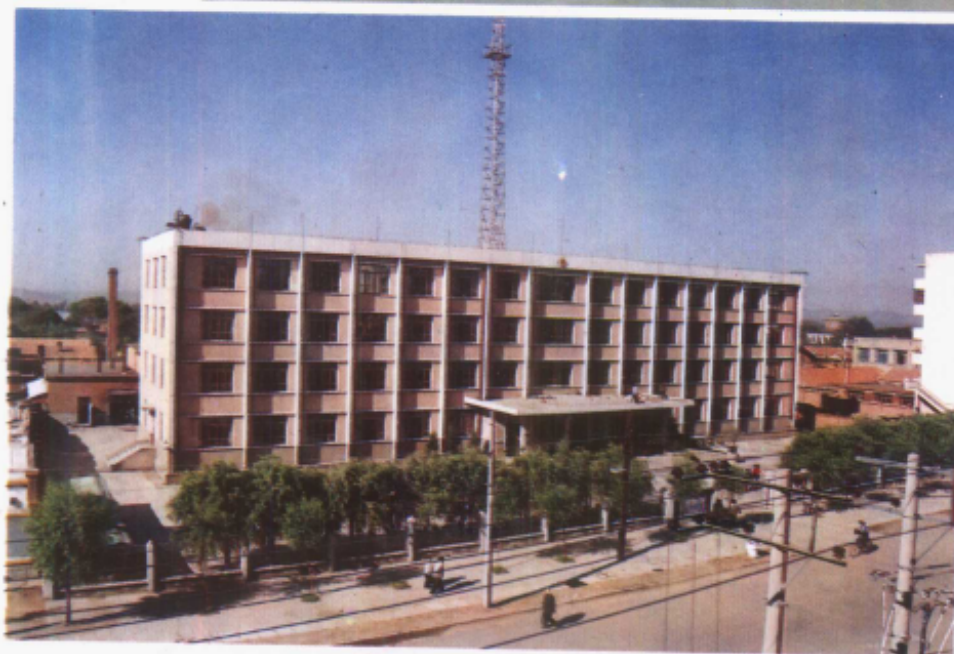
区机关办公楼
