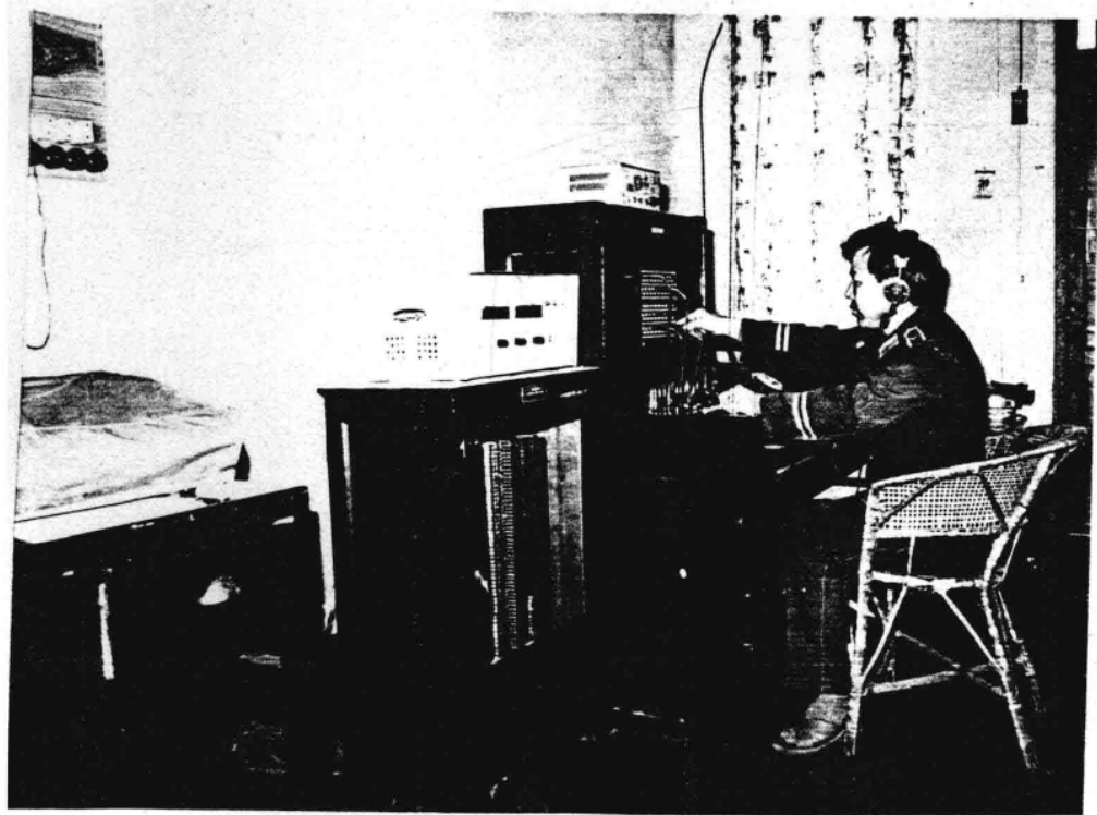
1988年元旦安装的50门共电交换机
