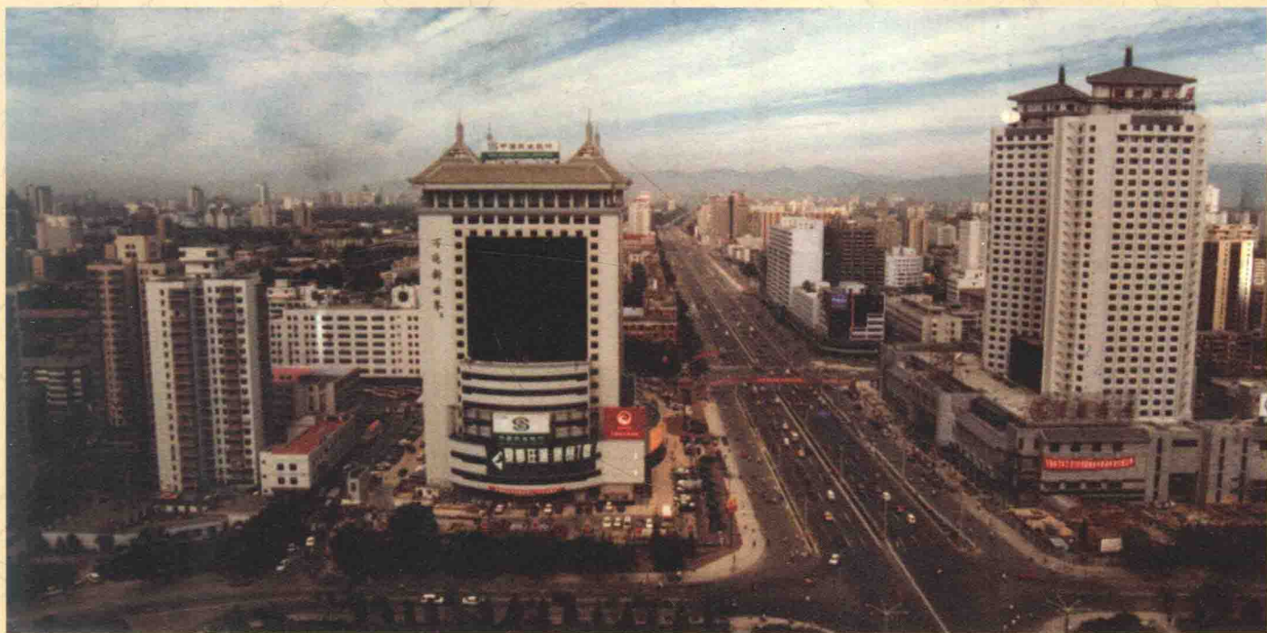
1997年6月26日，阜外大街拓宽工程竣工
