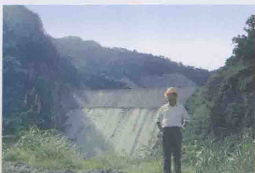
万安溪水电站水库大坝 即将竣工
