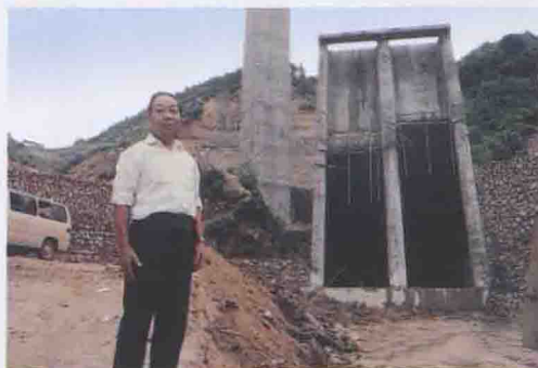
在万安溪水电站水库 工地——进水口
