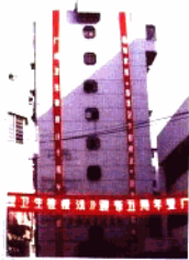
1989年在广州市广园路建成的广州卫生检疫所办公楼。
