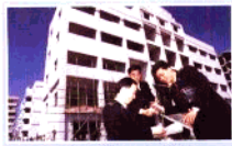
建设中的花都卫生检疫局办公楼
