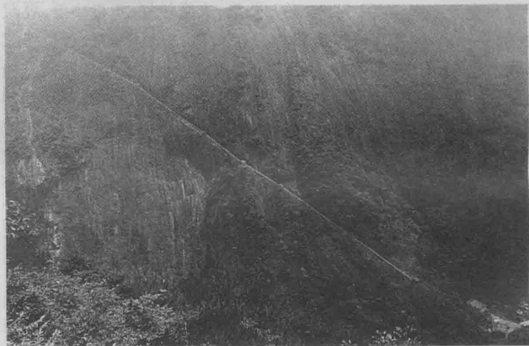
郭山顶电站引水管道
