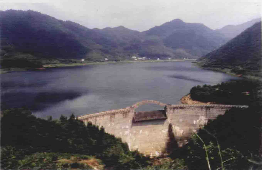
晓庄水库双曲拱坝
