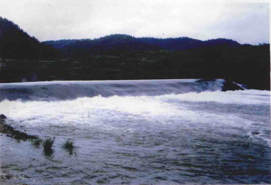
江村电站滚水坝
