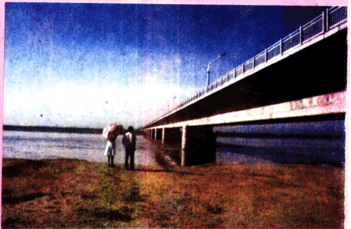
包西公路黄河大桥
