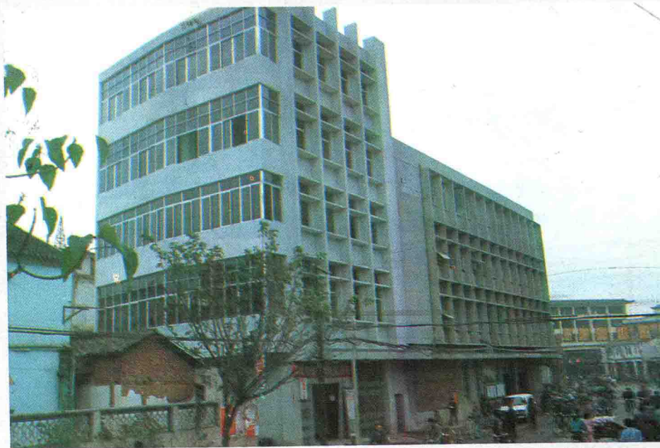
曾学路上的电讯大楼
