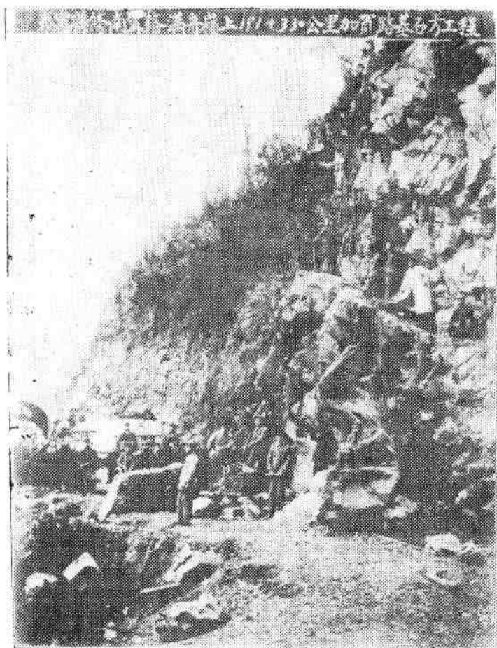
延建公路挽舟岭石方工程开凿情景
