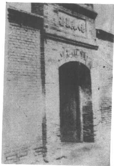
宁化府五台会馆旧址。
