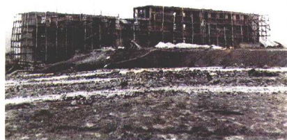
建设中的教学主楼
