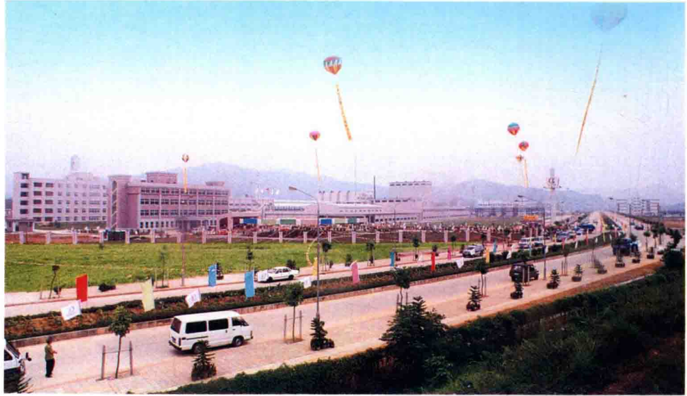
建设中的云埔(白云)工业区 Yunpu (Baiyun) Industrial zone under construction
