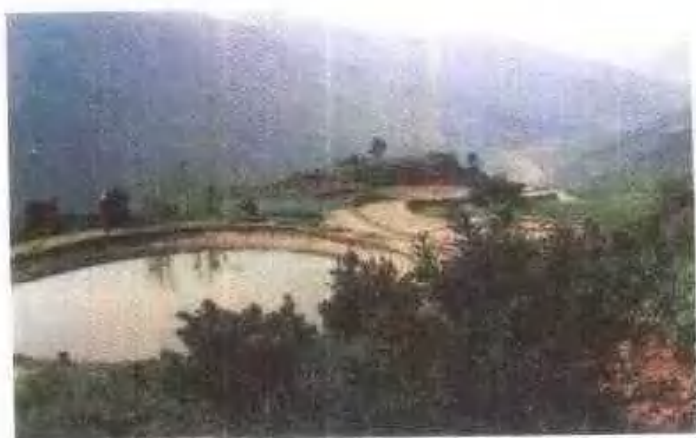
坡面水系配套工程 —— 秭归县彭家坡村高产 丰产脐橙基地蓄灌工程 —— 梅荣生摄
