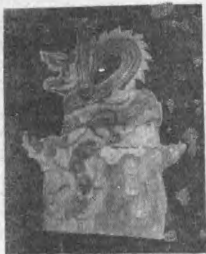
图44 山西古建筑的正吻
