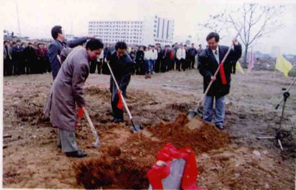
上饶分公司办公大楼奠基
