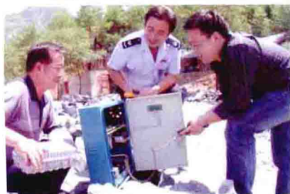
对辖区40余家矿产品开采业安装了远程税源监控系统，该行业全部实现了高科技监控管理
