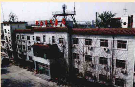
邢台市气象局办公楼
