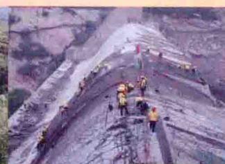
对病险水库进行除险加固工程
