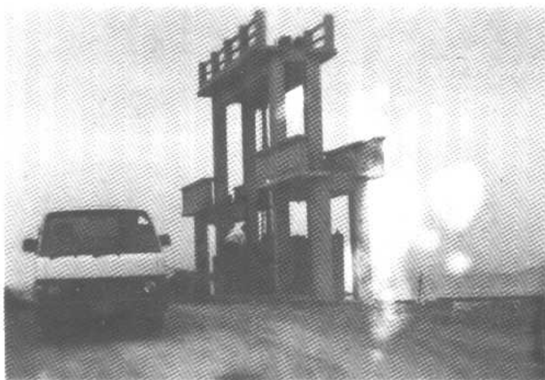
三龙水闸建成通车 (一九八八年)
